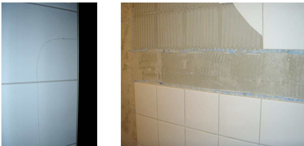
Figur 1 Sprickor kan vara både vertikala och horisontella. Sprickorna går genom kakelplattorna.
